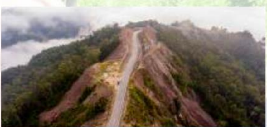
Gambar 9. Potret pembangunan jalan trans Papua yang membelah puncak perbukitan (Dokumentasi FWI)
