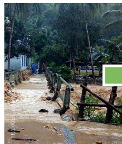
JEMBATAN SAAT SEDANG BANJIR
